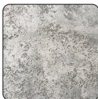
ШТУКАТУРКИ НА ЦЕМЕНТНОЙ ОСНОВЕ
